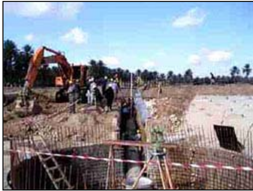
عمال يقومون بتحديد الوضع المتوازي لأنبوب تدفق المصفى في مشروع شرق دجلة لمعالجة المياه.
